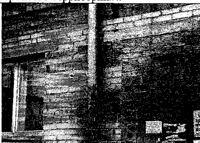
Фото 3,4. Наружный организованный водосток. Отсутствует нижнее сливное колено у труб наружного водостока, в результате отвода воды с кровли происходит замачивание наружной стены здания, что не соответствует разделу 9 СП 17.13330.2017 «Кровли. Актуализированная редакция СНиП II-26-76».
